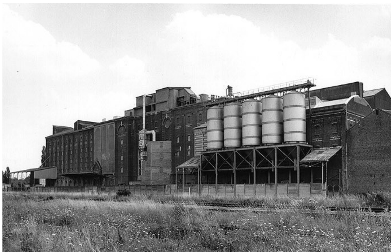
Vue de l'usine depuis la rue de Breuze (Façade nord)
