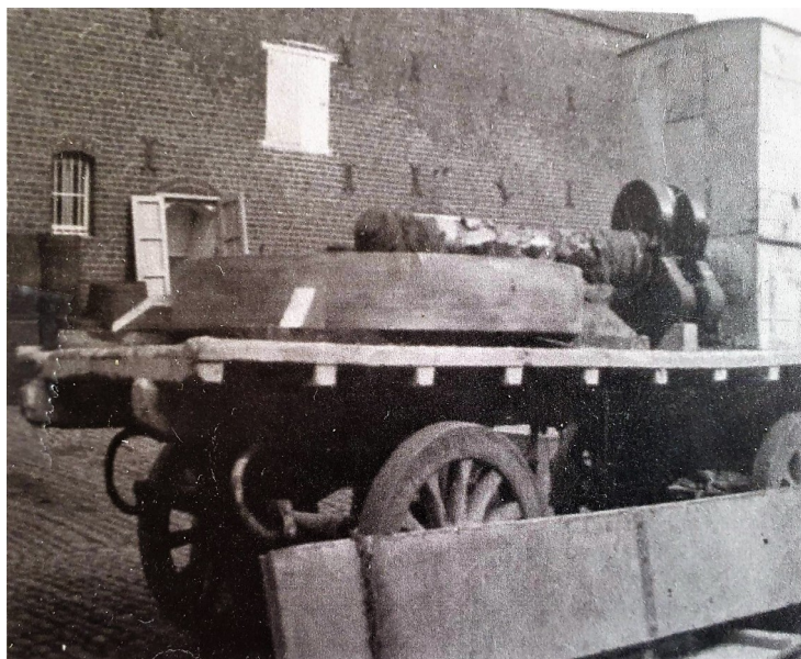
Matériel de forage - l'outil de forage descendant jusque 195 mètres
